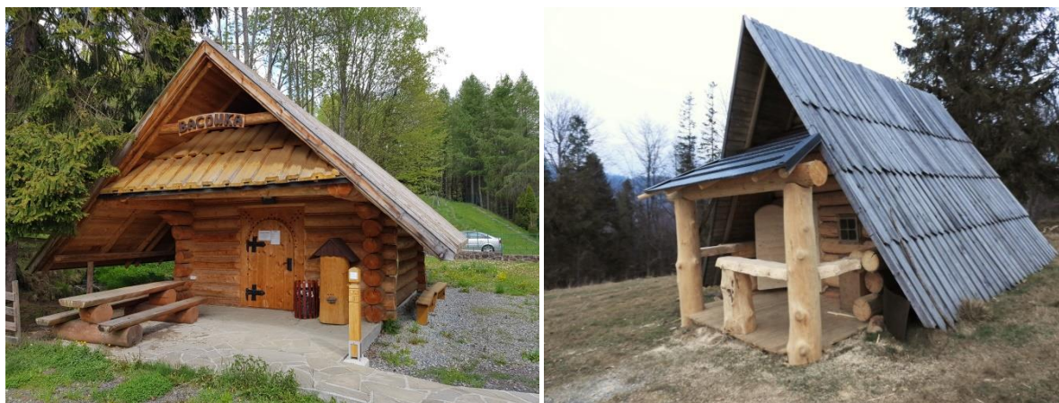
fot. 4. Przykłady infrastruktury pasterskiej zrealizowanej w ramach projektów Karpaty Łączą oraz Ochrony zbiorowisk nieleśnych na terenie Beskidzkich Parków Krajobrazowych
