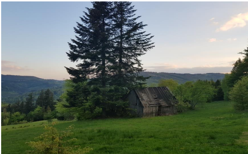
fot. 2. Niszcząca infrastruktura pasterska na Abrahamowie
